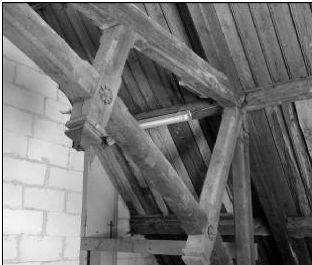
Deel van één van de vroeger zichtbare dakspanten en dakbeschoot van de Sint-Pauluszaal (Processiestraat).
